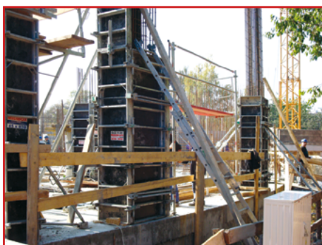
Formowanie słupów - płyty MIDI BOX i zamki szalunkowe
